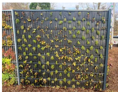
RANKO Pflanzen-Gabione – vorher
